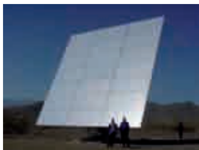
Foto 5. Heliostato Sanlúcar 90, de 21 facetas (3x7).
