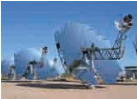
Foto 7. Disco parabólico + motor Stirling. Fuente: Archivo RENOVETEC.
