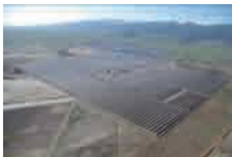
Foto 4. Planta termosolar de canales parabólicos. Fuente: REE.
