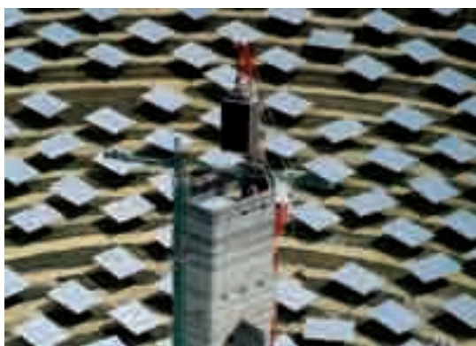
Foto 16. Detalle de la maniobra de colocación de panel absorbedor de receptor solar.
