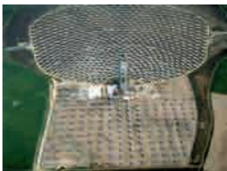
Foto 14. Vista aérea de la construcción de PS10 por abril de 2006 con la maniobra de izado de uno de los paneles absorbentes del receptor solar.
