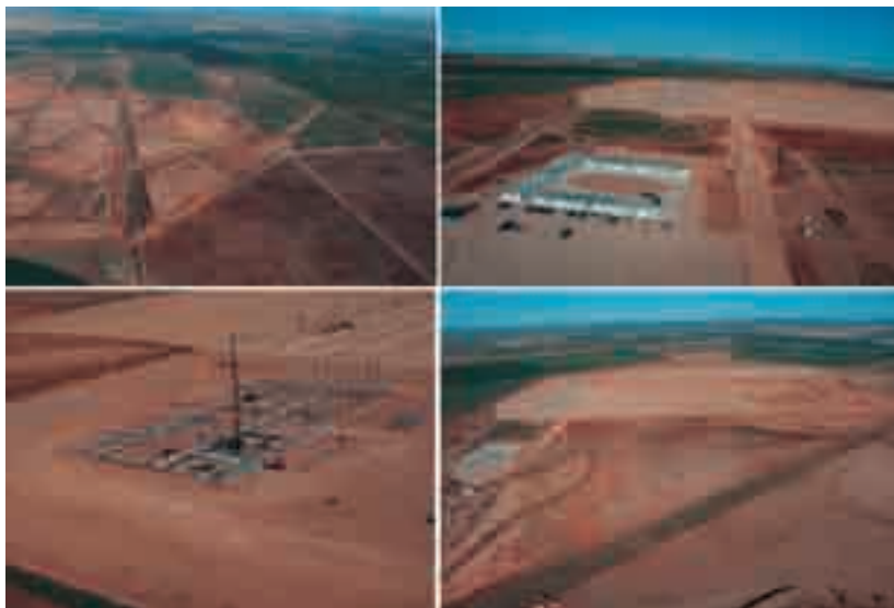
Foto 3. Movimiento de Tierras. De izquierda a derecha: desbroce, nave ensamblaje SCA, villa de contratistas, y plataformas campo solar.
