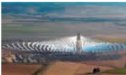
Foto 5. Planta termosolar de torre. Fuente: REE.
