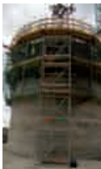
Fotos 7 y 8. Construcción de la torre empleando la técnica de encofrado deslizante. Hay dos días de trabajo entre la imagen de la izquierda y la derecha.
