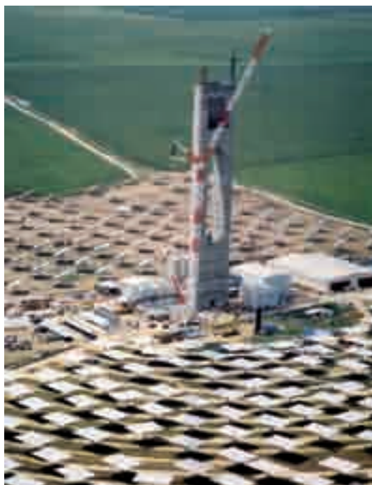
Foto 15. Maniobra de izado de panel absorbedor del receptor solar en abril de 2006.
