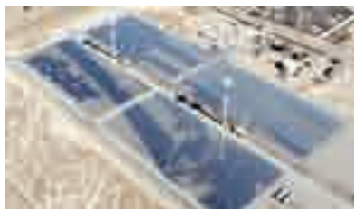
Vista aérea de la planta
