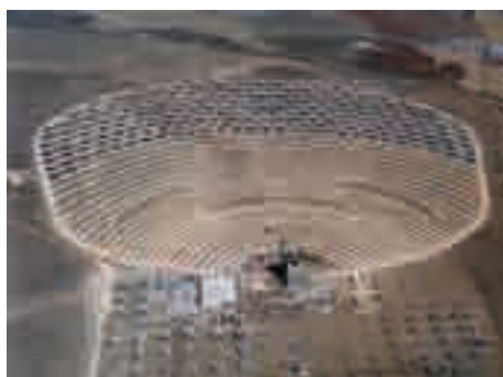
Foto 13. Vista aérea de la construcción de PS10 por octubre de 2005.
