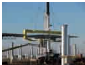
Foto 11. Montaje de heliostatos en el campo solar.
