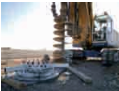
Foto 9. Ejecución de las torres de alta tensión.
