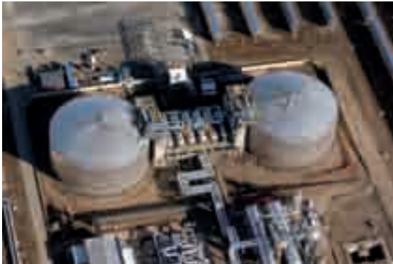
Foto 6. Sistema de almacenamiento térmico en una central CCP en construcción. Fuente: Archivo RENOVETEC.
