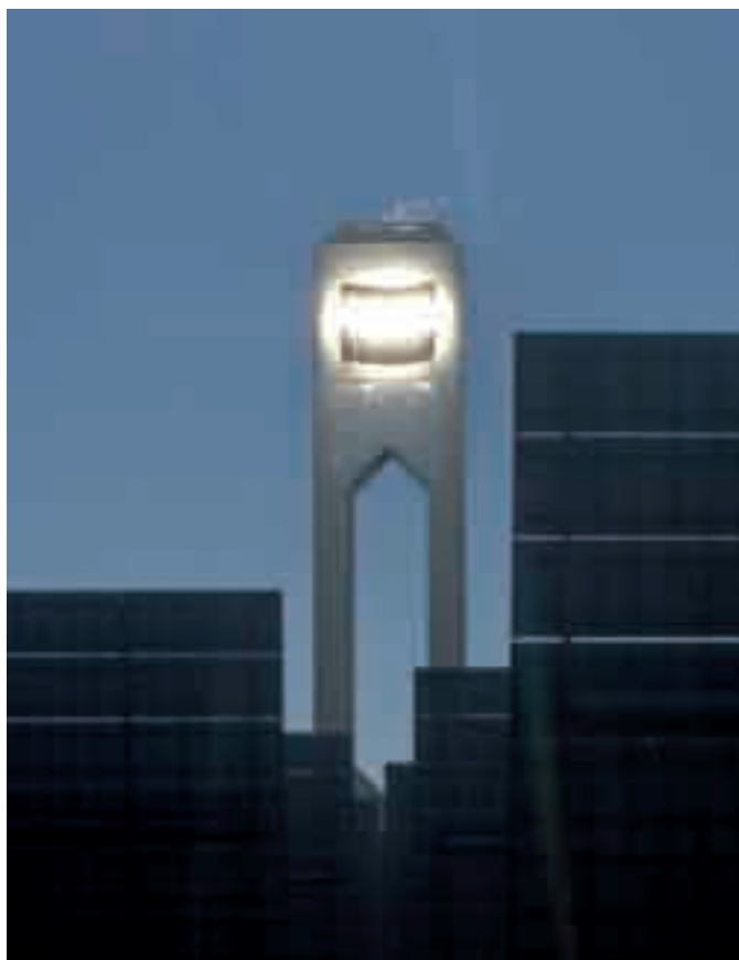
Foto 20. Ajuste del foco de PS10.
