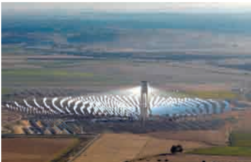
Foto 23. Vista aérea de PS10 en operación solar.
