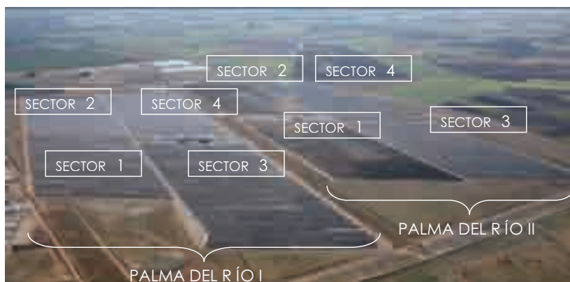
Foto 1. Vista general de las plantas de Palma del Río I y Palma del Río II. Fuente: Acciona Energía.
