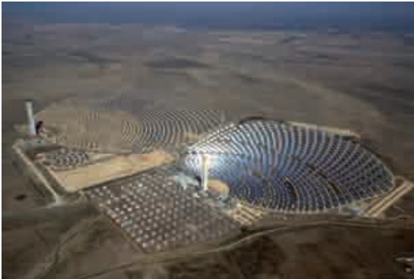
Foto 29. En primer plano PS10 en operación, PS20 al fondo en construcción.
