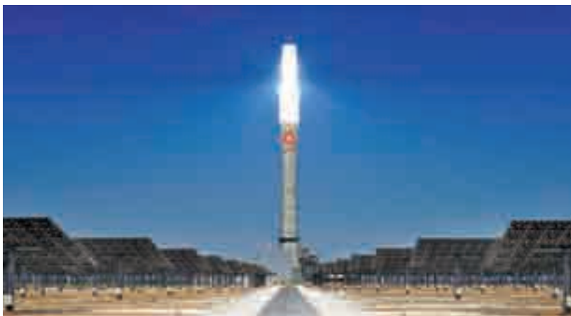
Foto 5. Vista del receptor central en operación.
