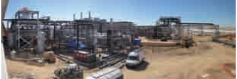
Foto 6. Montaje Tuberías Bloque de Potencia Astexol 2. Agosto 2011.
