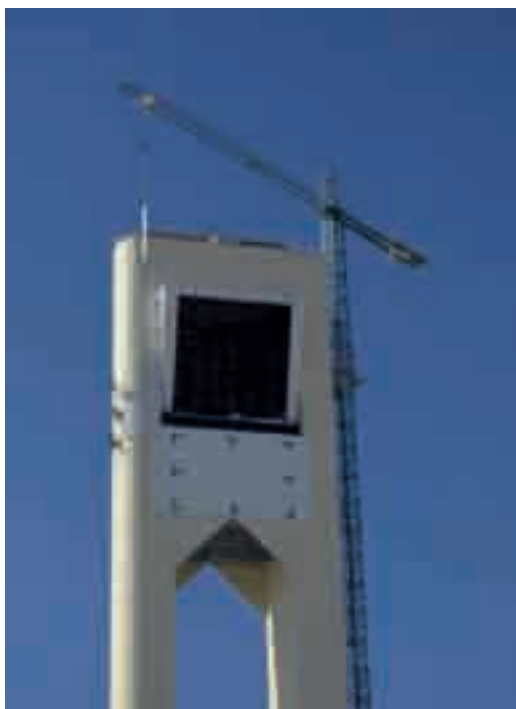
Foto 17. Trabajos de colocación por parte de los escaladores de las protecciones térmicas del fuste de la torre a la altura del receptor solar.
