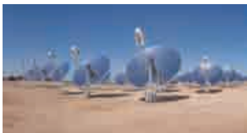
Foto 6. Planta termosolar con sistema de concentrador disco Stirling. Fuente: REE.
