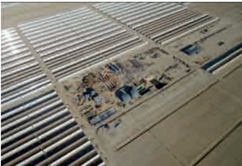
Foto 5. Instalación de Equipos Principales Aste 1A. Julio 2011.
